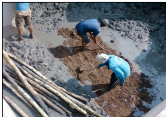
Gambar 3.3 : Contoh Dokumentasi Penghamparan Sirtu Pada Galian Konstruksi Penggantian Jaringan Perpipaan.
