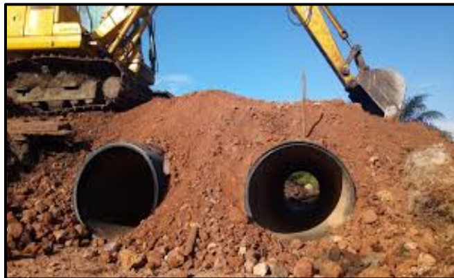
Gambar 3.6 : Contoh Dokumentasi Konstruksi Pengurugan / Pemadatan Tanah Di Setiap Sisi Jaringan Perpipaan.
