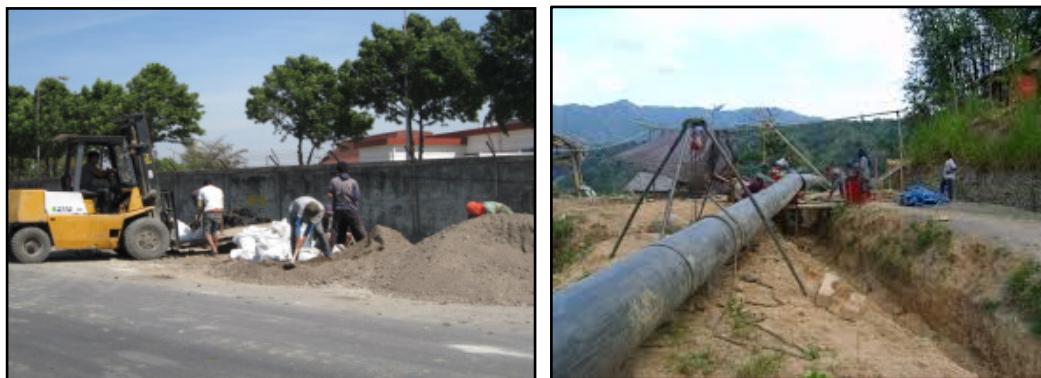
Gambar 3.4 : Contoh Dokumentasi Pengangkutan Dan Penurunan Pipa / Perpipaan Menggunakan Forklift dan Katrol.
