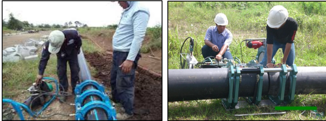
Gambar 3.5 : Contoh Dokumentasi Konstruksi Penyambungan Pipa / Perpipaan (Welding Joint).
