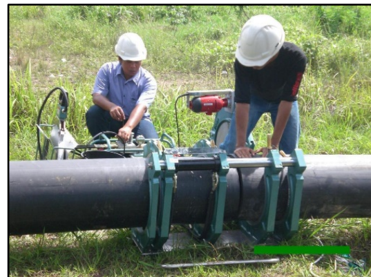
Gambar 3.5 : Contoh Dokumentasi Konstruksi Penyambungan Pipa / Perpipaan ( Welding Joint ).
