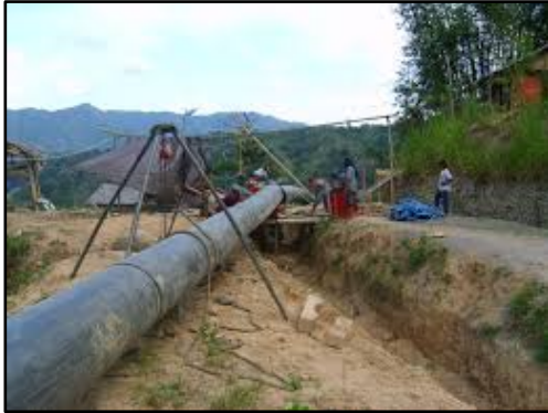
Gambar 3.4 : Contoh Dokumentasi Pengangkutan Dan Penurunan Pipa / Perpipaan Menggunakan Forklift dan Katrol.
