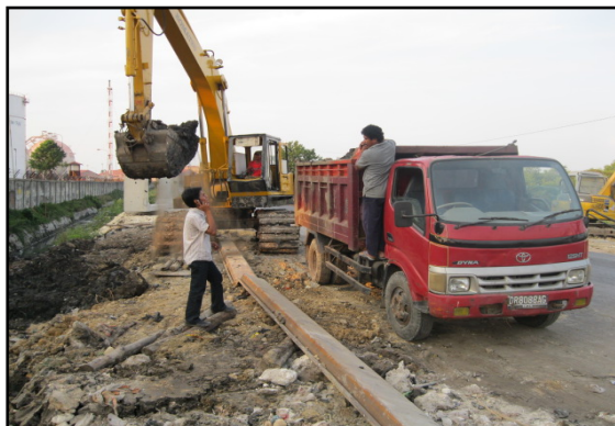
Gambar 3.2 : Contoh Dokumentasi Galian Konstruksi Pergantian Jaringan Pipa Secara Mekanis (Menggunakan Excavator).
