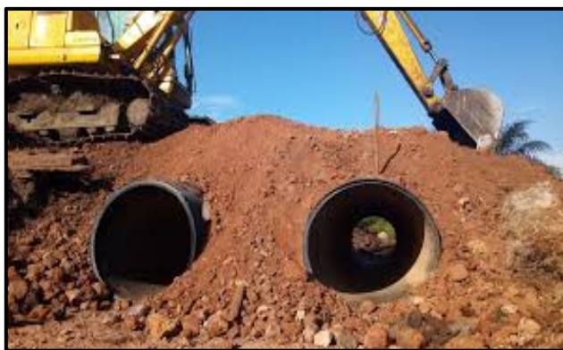
Gambar 3.6 : Contoh Dokumentasi Konstruksi Pengurugan / Pemasatan Tanah Di Setiap Sisi Jaringan Perpipaan.
