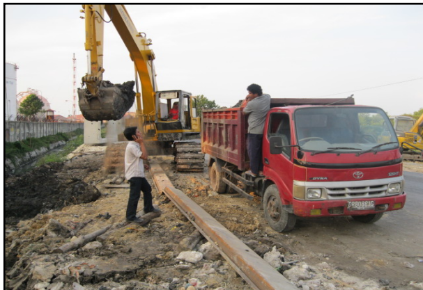
Gambar 3.2 : Contoh Dokumentasi Galian Konstruksi Pergantian Jaringan Pipa Secara Mekanis (Menggunakan Excavator).
